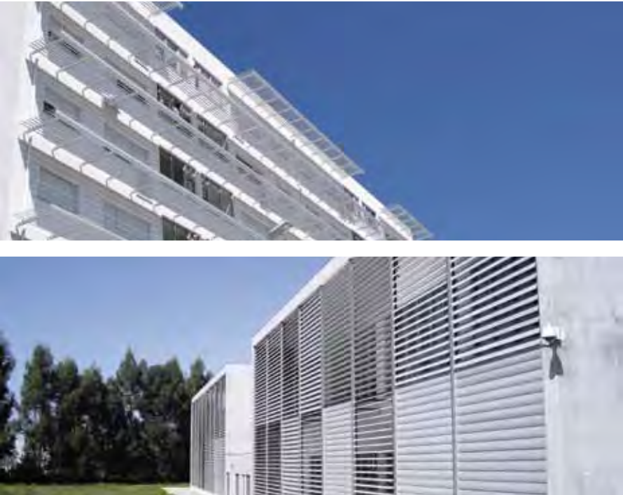
Vila Nova de Gaia, lamas de sombreado en el edificio de viviendas sociales “Vila D’Este” (arriba) y lamas de sombreado regulables en el edificio de servicios “InovaGaia” (abajo).
