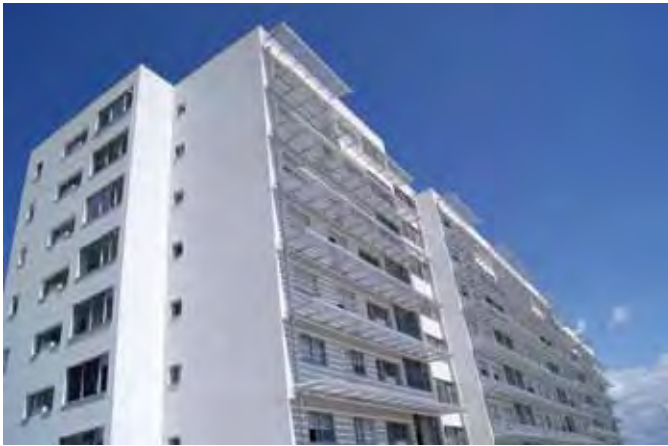
Vila Nova de Gaia, Vila D'Este, rehabilitación de edificios de viviendas sociales, interviniendo en el envoltente exterior en el aislamiento térmico y los acristalamientos.
