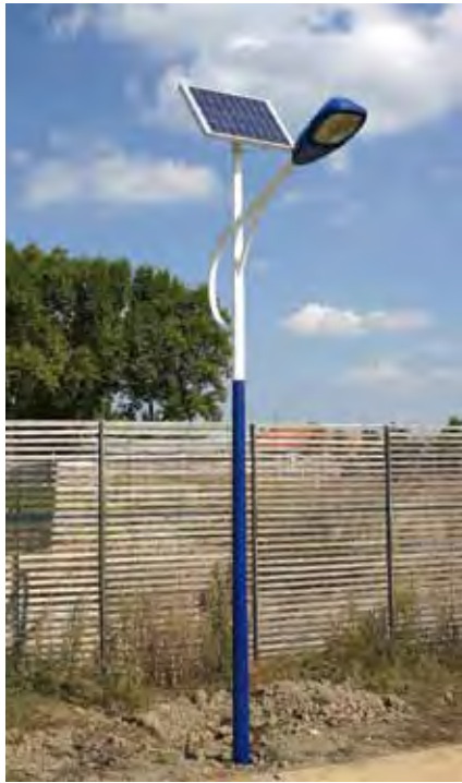
Toulouse, luminaria con panel solar fotovoltaico en el espacio público de Bourderouge.
