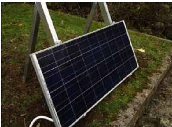
Os painéis alimentam um regulador de carga, que proporciona uma tensão contínua de potencial fixo. O referido regulador alimenta em paralelo o equipamento de telecomando e uma bateria, e permite que, quando o painel não pode gerar energia por causa das condições climáticas, seja a bateria a encarregada de alimentar os equipamentos.
