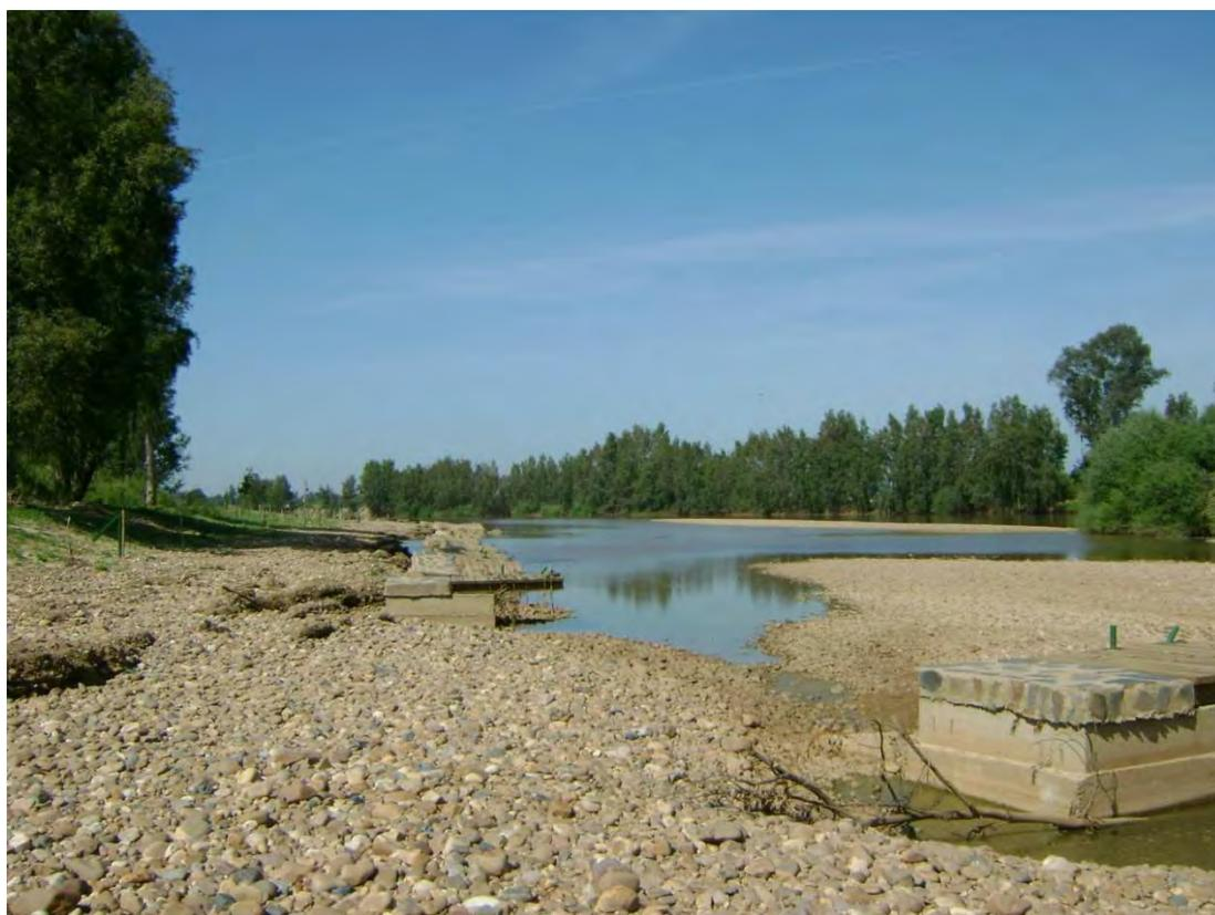
Figura 115. Presencia de pesquiles en el tramo 3. Se puede observar la formación de pozas en sus alrededores. Fuente: Depaex.
